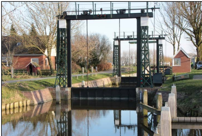
Het Oosterdijkshornerverlaat, (met 'Stoney-schuiven') uit 1928
