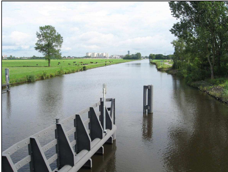
Aduarderdiep tussen Nieuwbrug en Vierverlaten
