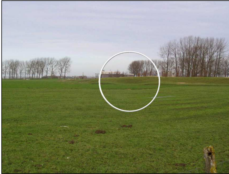
Een verzakte dijk bij de Dorkwerder sluis
