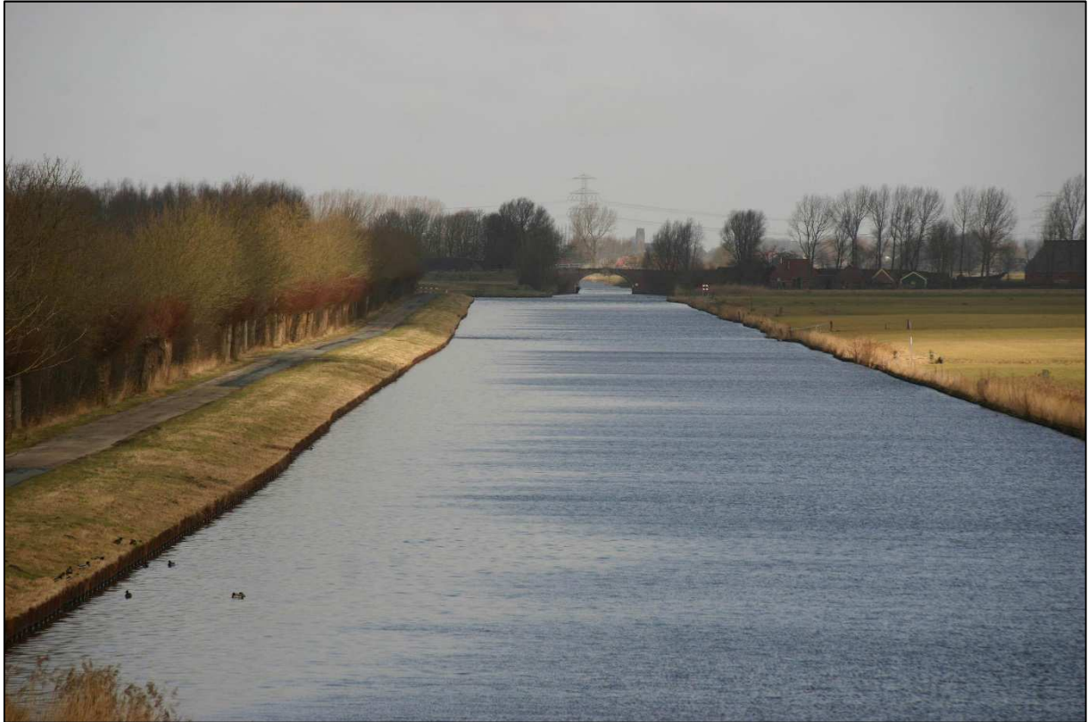
Het Aduarderdiep, de Steentil en Garnwerd, gezien vanaf Nieuwklap
