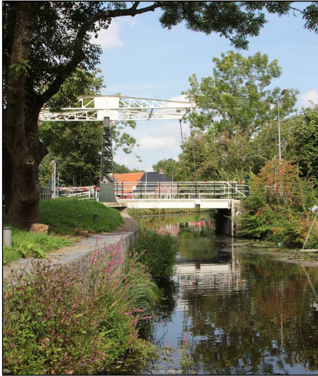
De Regattabrug in Oosterhoogebrug is de 'hogebrug' die in of kort na 1424 over het Damsterdiep is gelegd. Ze wordt in 1427 voor het eerst in een schriftelijke bron genoemd en heeft het huidige stadsdeel Oosterhoogebrug zijn naam bezorgd.
