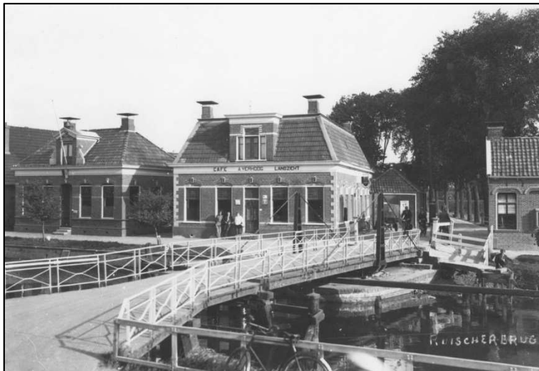
De in 1869 gebouwde draaibrug over het Damsterdiep. Waarschijnlijk is 444 jaar eerder op dezelfde plek de eerste Ruischerbrug gebouwd.
