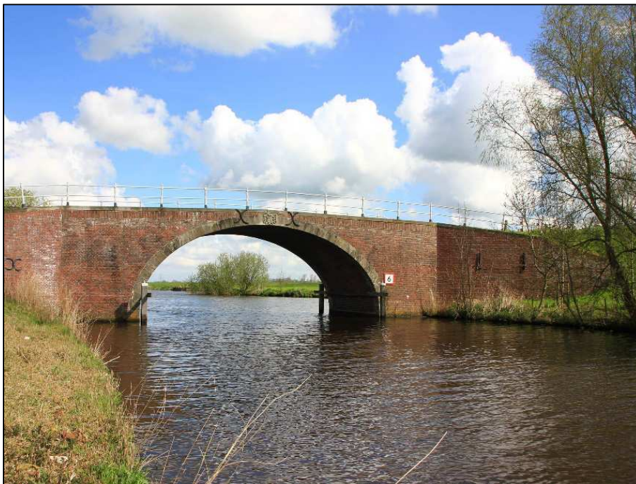
Aduardersteentil na de restauratie
