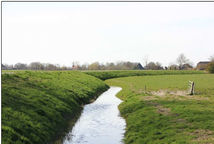
De Middagsterdijk (waarop de Medenerweg) verheft zich ruim 1 meter boven het aangrenzende land.
