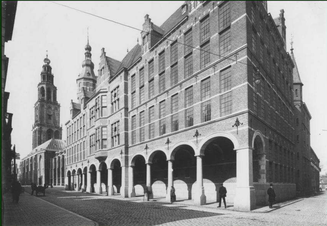
Het nieuwe Rijksarchiefgebouw aan de verbrede St Jansstraat
