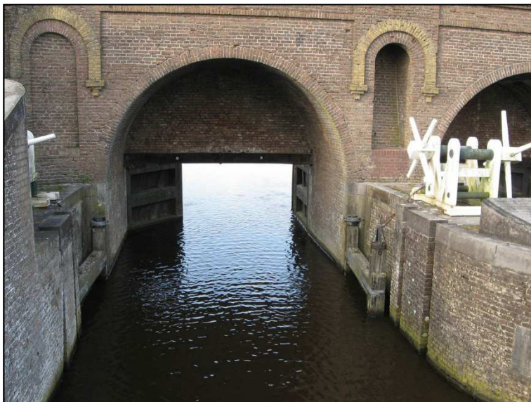
Oostelijke sluis te Aduarderzijl
