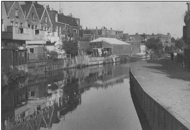
Boterdiep met Rodeweg (c. 1925) De foto is gemaakt door L. Houttuin. (GrA T1785-0870)
